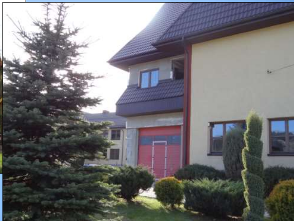
Rozbudowa budynku Remizy OSP w Rabie Wyżnej 2013r. 108tys.zł
