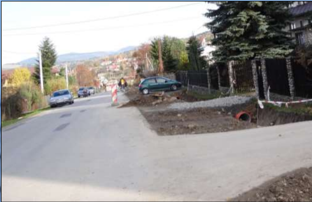
Chodnik w Rabie Wyżnej przy drodze powiatowej. 2013r.
