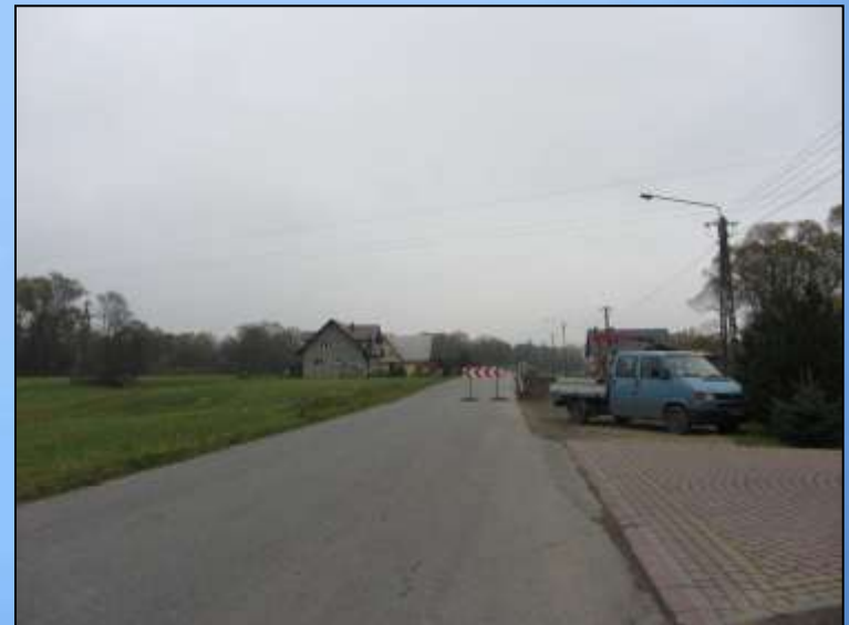
Chodnik w Skawie przy drodze powiatowej. 2011-2012r.
