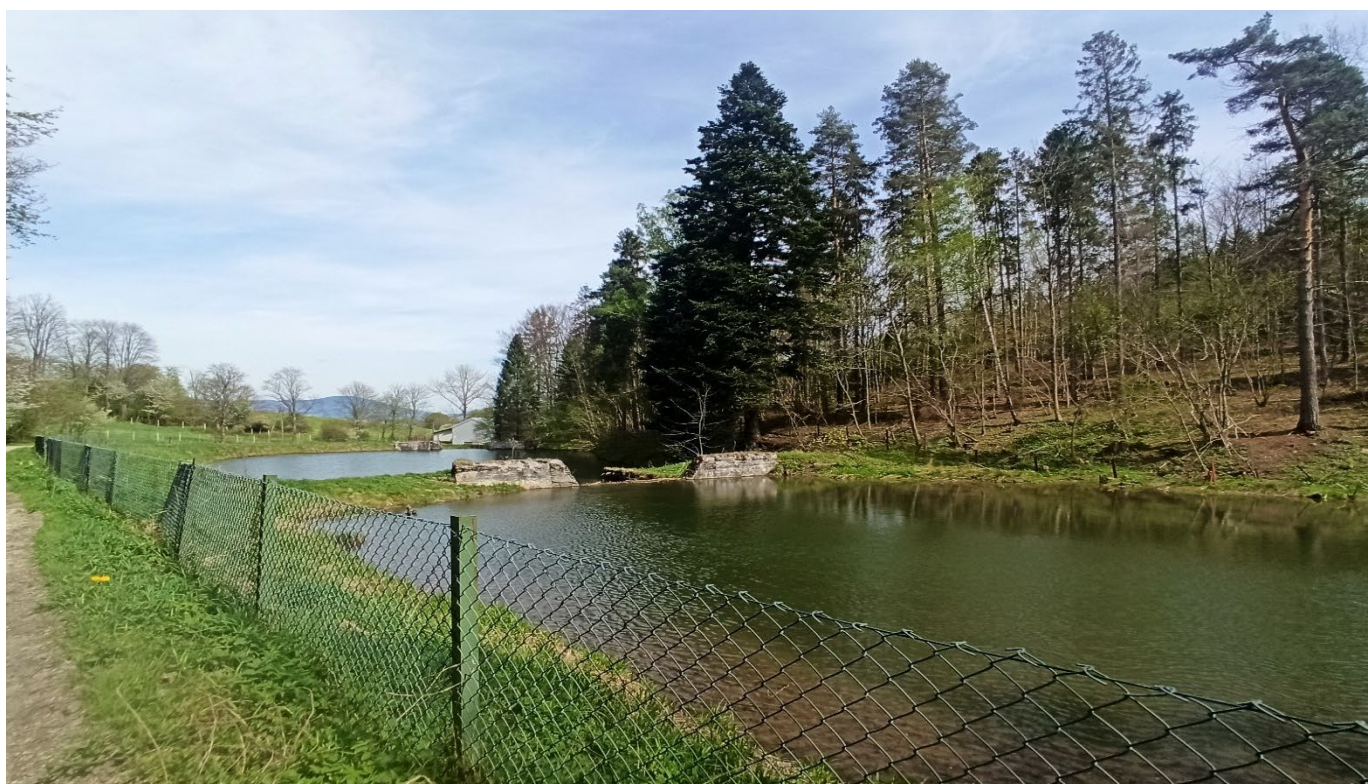
Fot. 10 Ujęcie wodny na potoku Kosicznym (Raba Wyżna)
