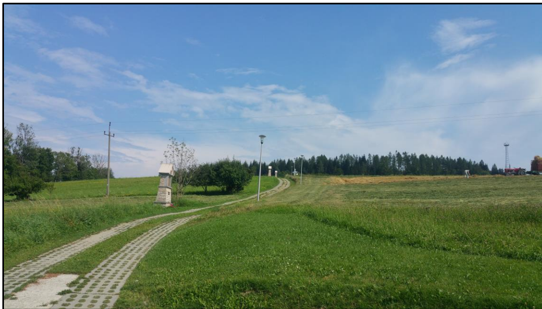
Raba Wyżna – 2018r. Budowa oświetlenia do Krzyża Milenijnego; 60,5 tys. zł
