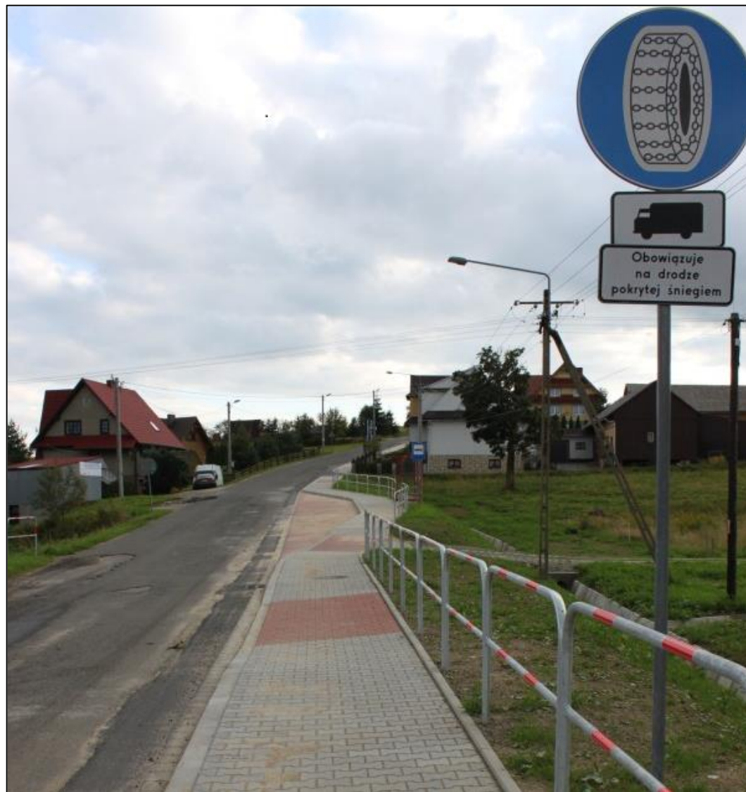
Chodnik w Bukowinie Osiedle przy drodze powiatowej - 2017r.
