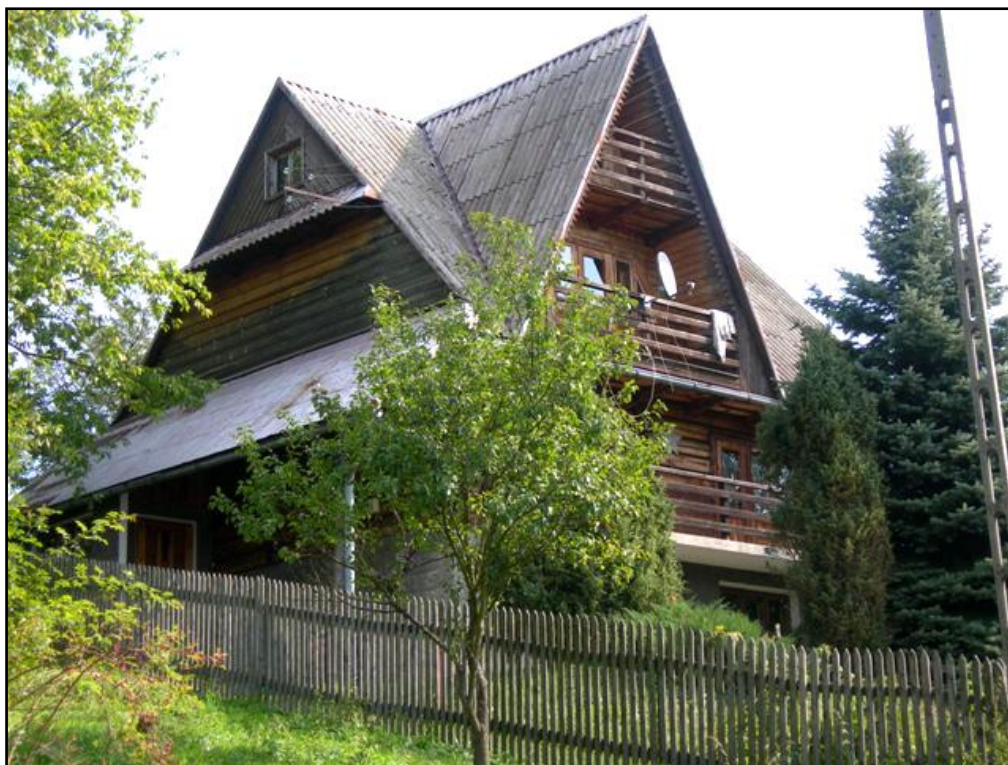
Rys. 6. Zdjęcie obrazujące wykorzystywanie wyrobów azbestowo-cementowych jako element pokrycia dachowego (eternit falisty), źródło: zdjęcie własne – inwentaryzacja w terenie
